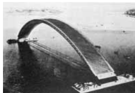
fig 17 EUGENE FREYSSINET (1879-1962) cimbra flotante. Luz=188 puente Plougastel, Bretaña, Francia 1922-30
