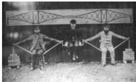
fig 25 BAKER & FOWLER Forth Bridge, Escocia. 1890 Representación humana del funcionamiento del puente y vista general del primer gran puente construido en acero de la historia.
