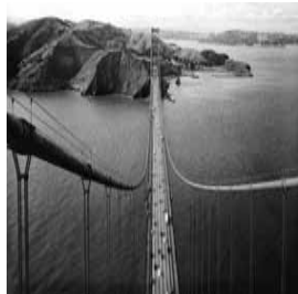
fig 16 puente GOLDEN GATE, 1932-37 bahía de San Francisco, USA Joseph Baerman Strauss (1870-1938) LUZ tramo suspendido=1280m
