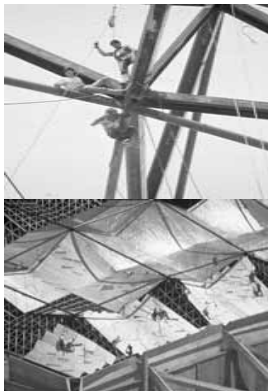
fig 41 FELIX CANDELA Palacio de los Deportes, Méjico, 1968. LUZ=140m simbiosis de elementos reticulares de acero superficies de doble curvatura.
