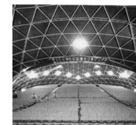
fig 38 EMILIO PEREZ PIÑERO FESTIVALES DE ESPAÑA, 1966 cúpulas reticulares macladas realizadas con tramos hexagonales. luz en la base de los casquetes=31m
